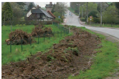
↑ Préparation de l'emprise du talus.
