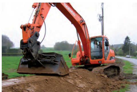
↑ Nivellement des flancs et du sommet.
