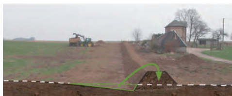
1 Exemple de décapage en pied de talus.
